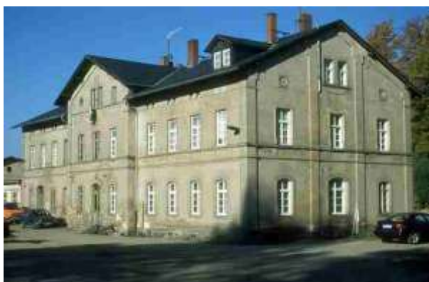
Abb.: Klingenberg Empfangsgebäude 2000
