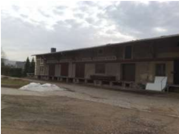
Abb.: Güterrampe in Burkersdorf
