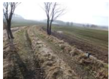
Abb. rechts: Bahndamm Richtung Oberbobritzsch
