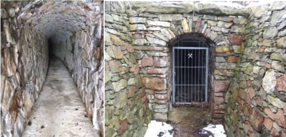
Mundloch „Tiefer Friedrich Christoph Erbstolln“ im Bobritzschtal
