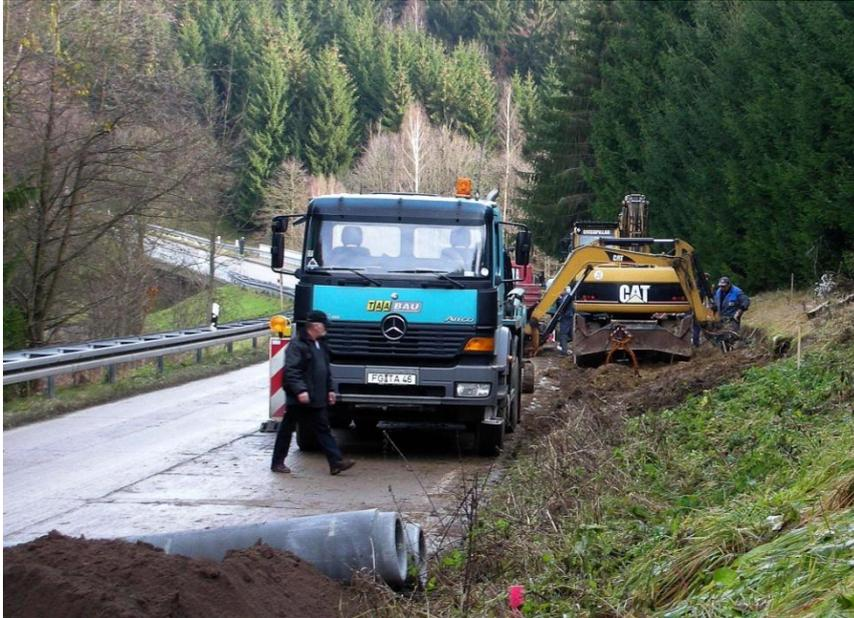
Bild 6: Bau der Straßenentwässerung auf dem Abschnitt Burkersdorf-Dittersbach
