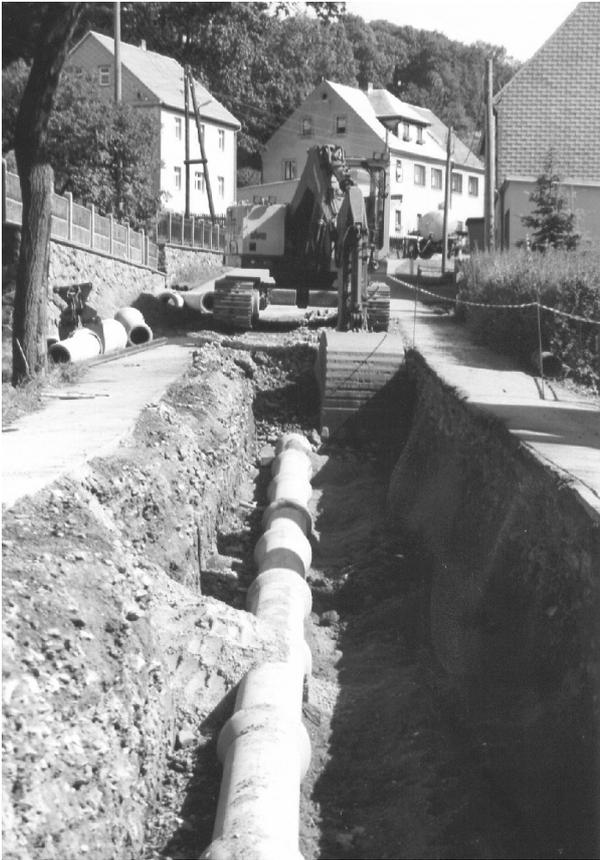
Bild 17: Bau der Abwassertrasse
